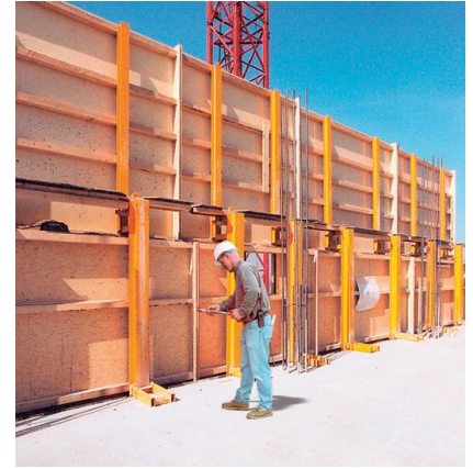
ŞEKİL 21 – Rüzgar Güvenlik Panelleri (PERI KALIP ve İSKELE SİSTEMLERİ, PERI Safety Systems Handbook , 2009, S.76)
