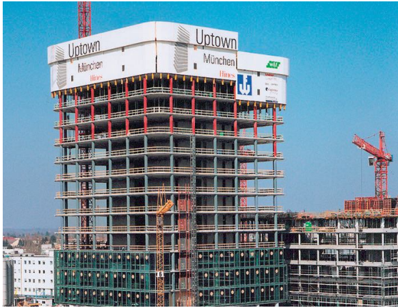
ŞEKİL 21 – Rüzgar Güvenlik Panelleri (PERI KALIP ve İSKELE SİSTEMLERİ, PERI Safety Systems Handbook , 2009, S.76)
