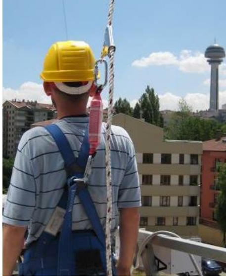
ŞEKİL 6:Personel Düşme Durdurma Sisteminin Doğru Kullanımına Örnek
